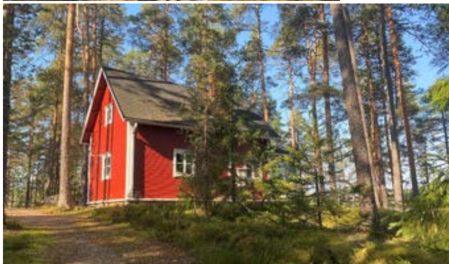
Voimassa olevassa rantayleiskaavassa sr-merkinnällä osoitettu vanha huvilarakennus.
