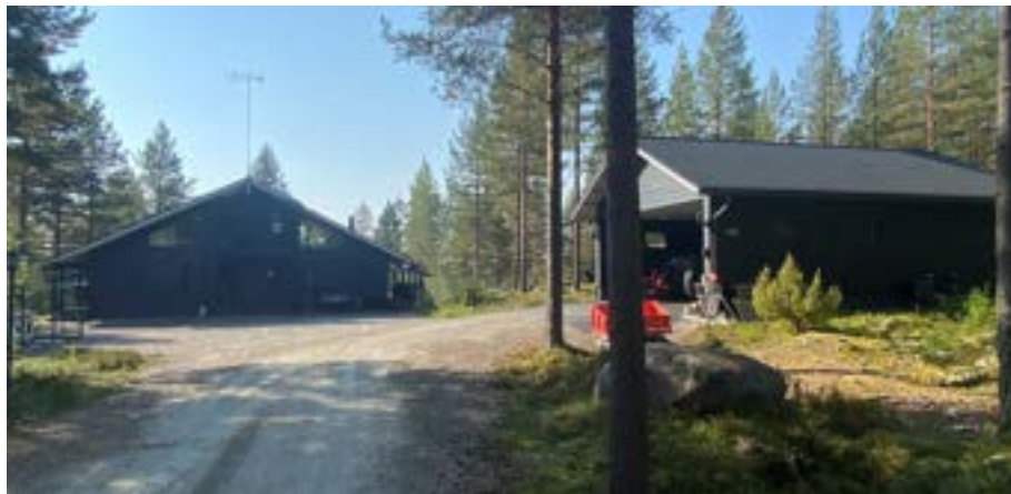
Olemassa olevaa rakentamista Väliveden itärannalla kiinteistöllä 989-402-2-73.
