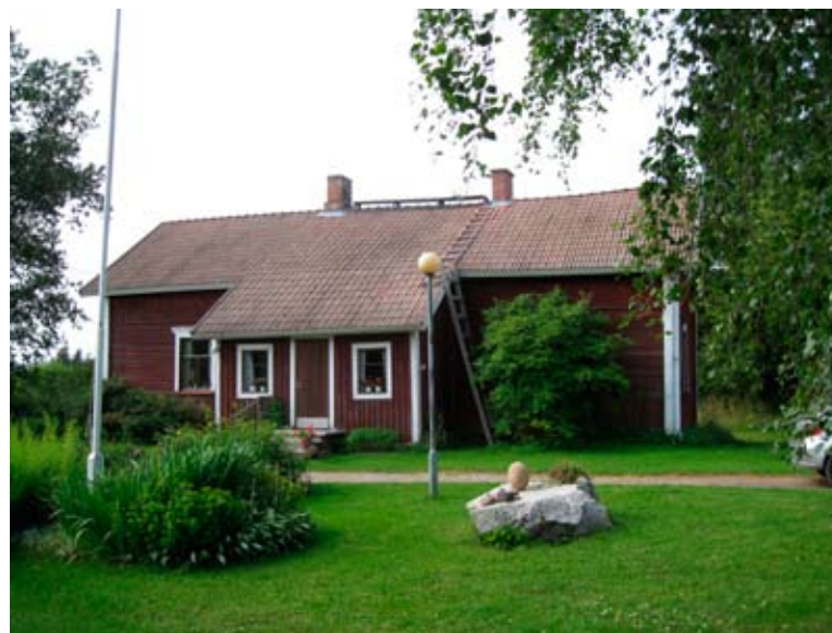
Mäkelän vanha päärakennus
