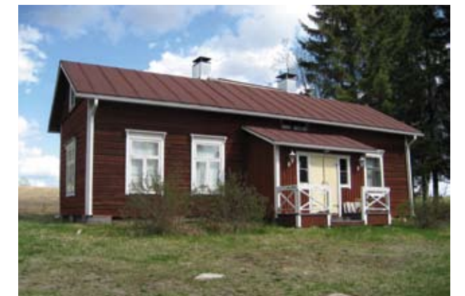
Rämälästä lohkaistun Kuminaniityn punamultainen päärakennus.
