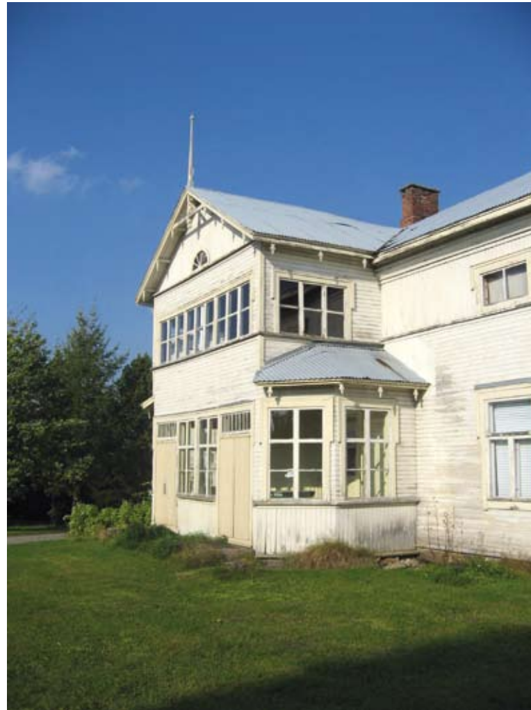
Kauppalan kaksikerroksinen kuisti
