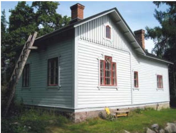
Ratavartijan mökki ja sauna/pakarituparakennus
