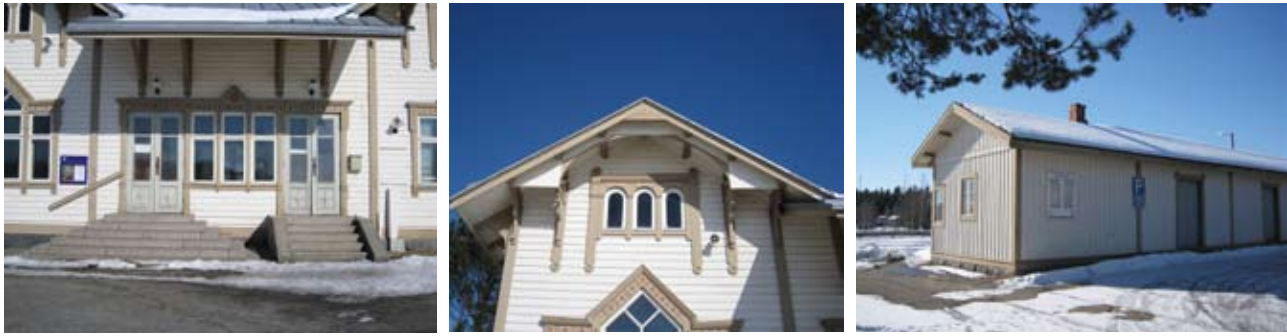
Ähtärin aseman pääsisäänkäynti vasemmalla, julkisivun yksityiskohta keskellä, oikealla ulkorakennuksen päätyä.
