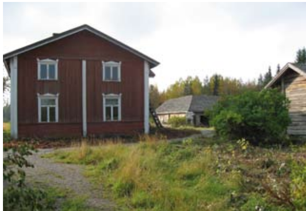
Kellomäen pihapiiri koostu useista rakennuksista.
