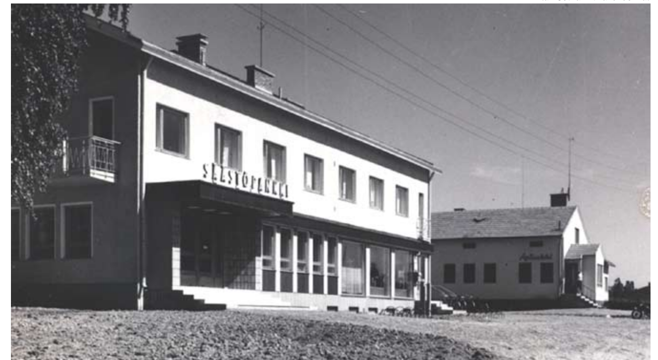
Säästöpankin talo ja takana apteekkirakennus 1950-luvulta
