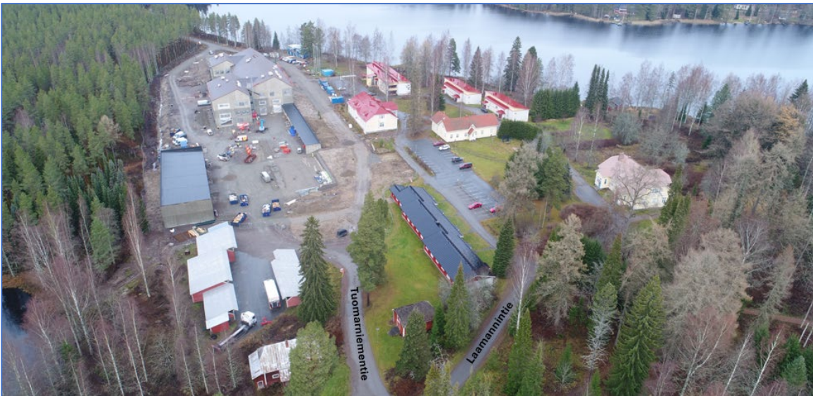
Kuva 3. Viistailmakuva (syksy 2024) alueen länsirajalta kohti pohjoista. Kuvassa vasemmalla rakenteilla oleva kampusrakennus sekä katokset. Katosten edustalla molemmin puoli Tuomarniementietä vanha käpykaristamo sekä käpyaitta. Rannassa kolme asuntolarakennusta, keskellä ja oikealla 1900-luvun alun rakennuksia (opetus- ja hallinto- sekä vuokratiloja) sekä edustalla keskellä asuntolarakennus. © Plandea
