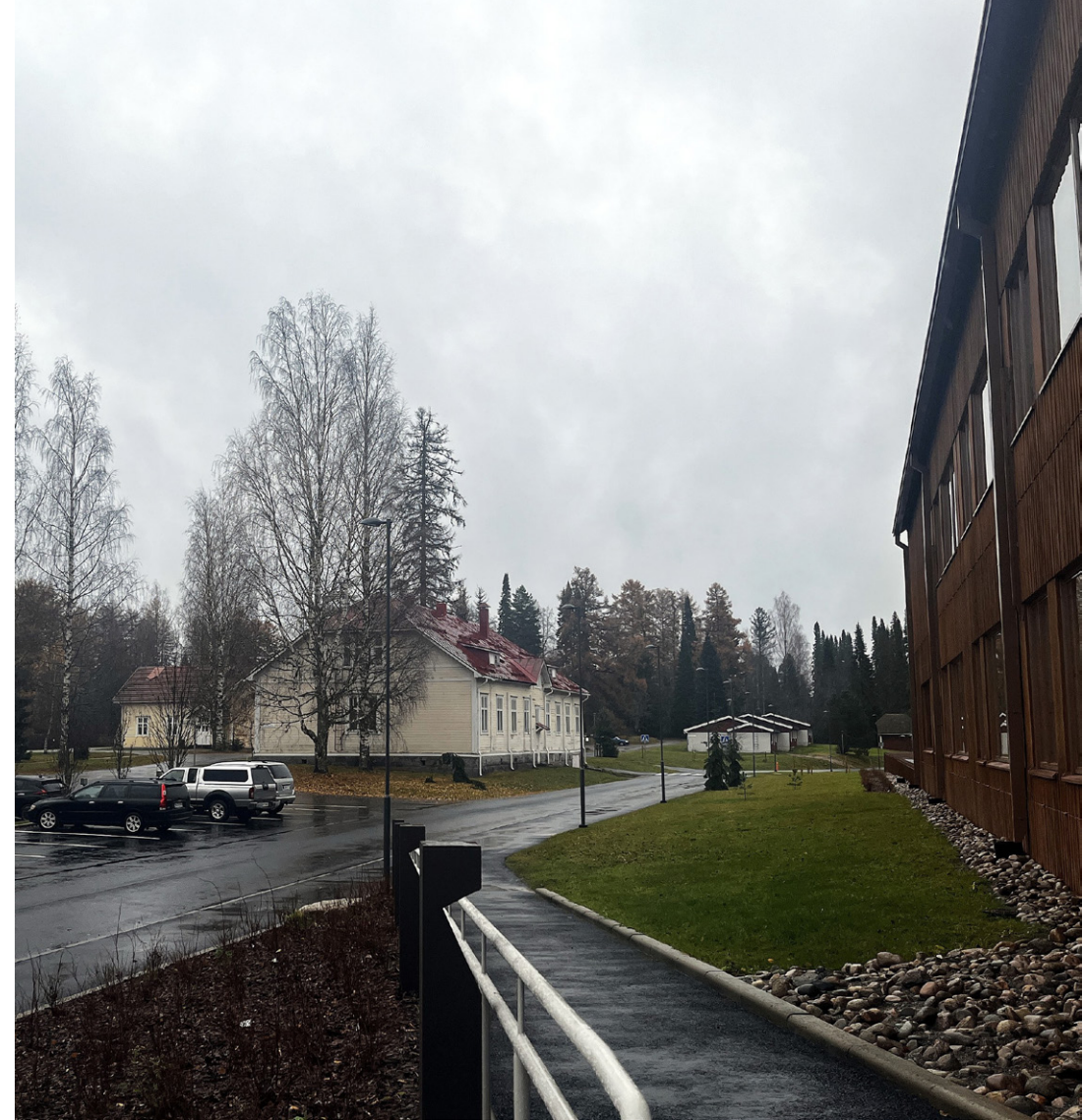
Kuva yllä: Näkymä uuden kampusrakennuksen sisäänkäynniltä Tuomarniementielle. Kuvassa etualalla näkyy vuonna 1914 valmistunut entinen oppilaiden majoitusrakennus. Taustalla vasemmalle sijoittuu Kurssirakennus eli Vellikellotalo (rv. 1905) ja oikealle opiskelija-asuntola (rv. 1977).
