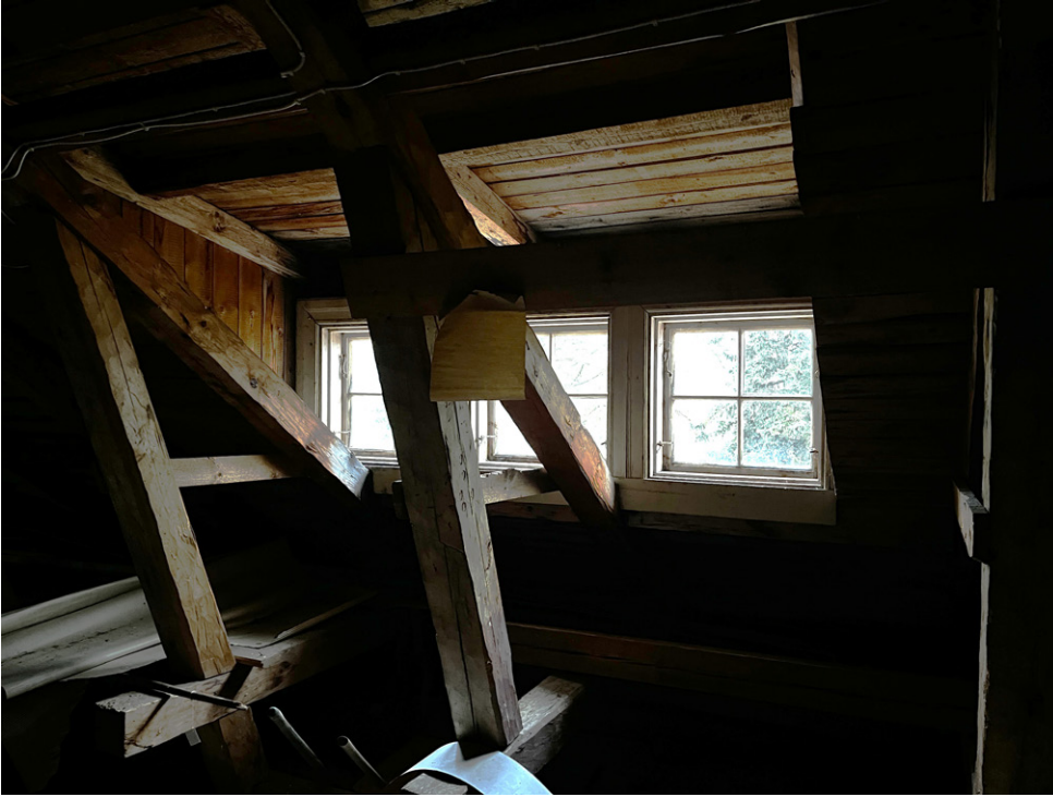
Kuva yllä: Rakennuksen kylmä ullakotila on säilynyt sisätiloiltaan alkuperäisenä.
