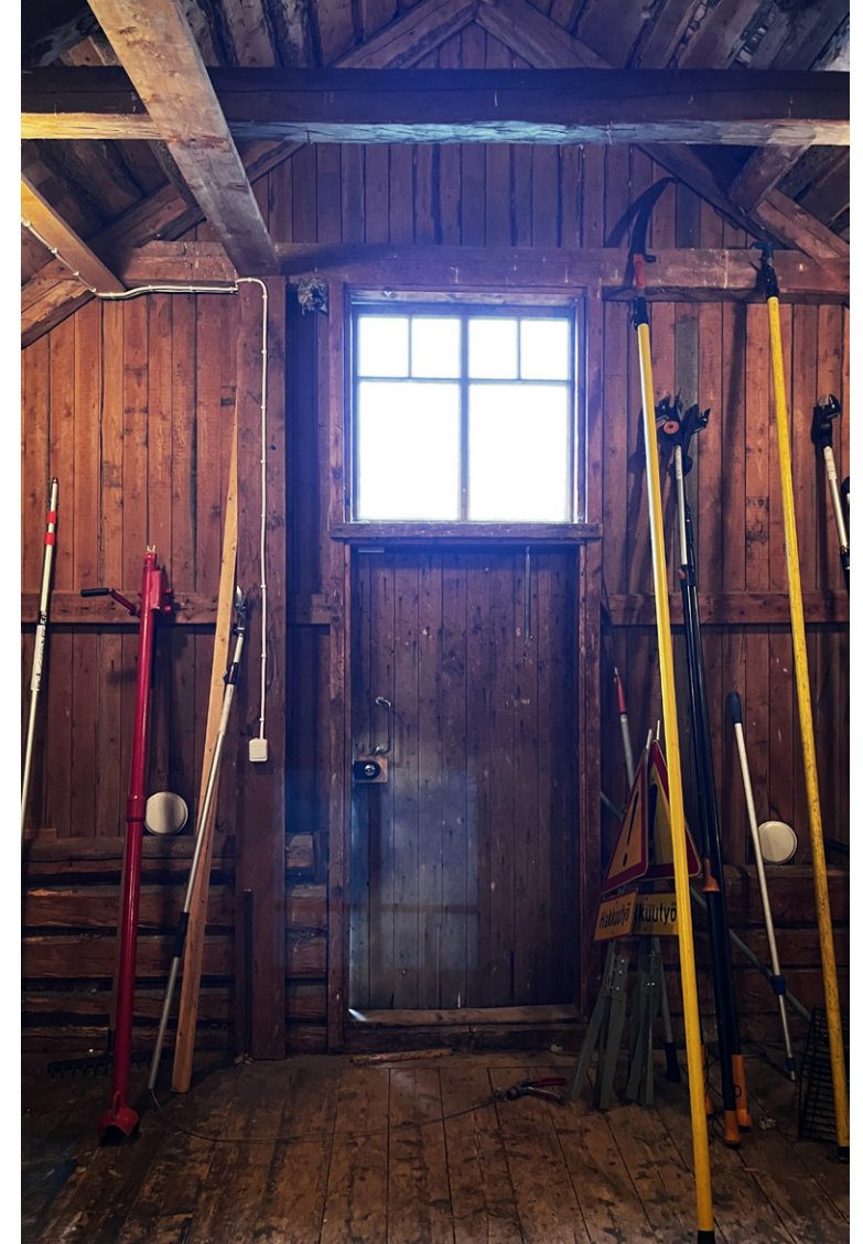
Kuva yllä vasemmalla: Näkymä pääkerroksen itäpäädyssä sijaitsevasta luokkarakennuksesta. Seinien puolipaneelit ovat alkuperäisiä.
