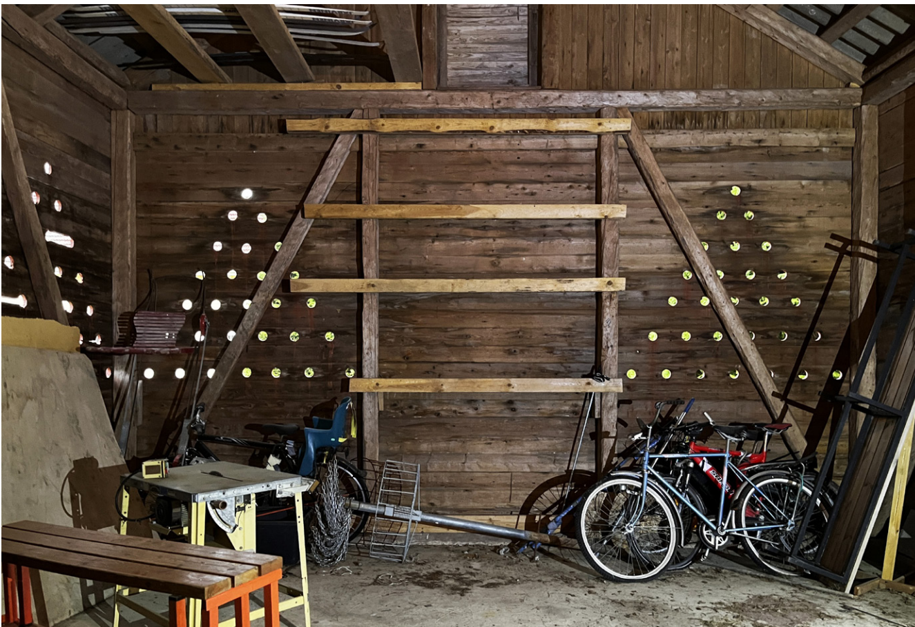
Kuva vasemmalla: Sisänäkymä piharakennuksen puurankarakenteisesta osasta. Tilan kolmella sivulla on julkisivulaudoituksessa tuuletusrei'itykset, jotka on sommiteltu kolmiomaisen kuusipuun muotoon.
