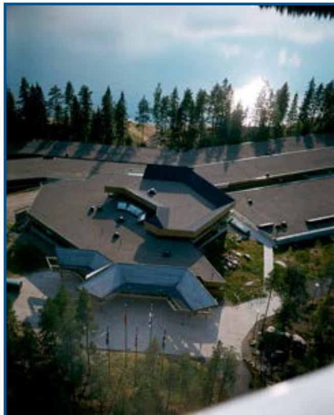
KUVA 17: Hotellin tasakatot vanhassa arkistokuvassa. Ravintola-osan katto nousee korkeimmalle ja sitä kannattavat liimapuupilarit ja -palkit, jotka on jätetty ravintolan sisätiloissa näkyviin.
