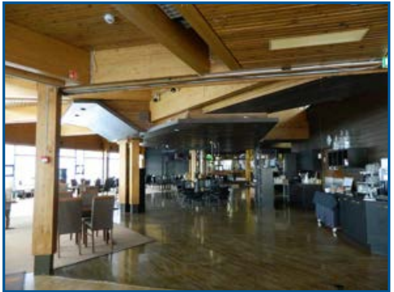
KUVA18 (yllä): Avara ravintolasali kattorakenteineen.
