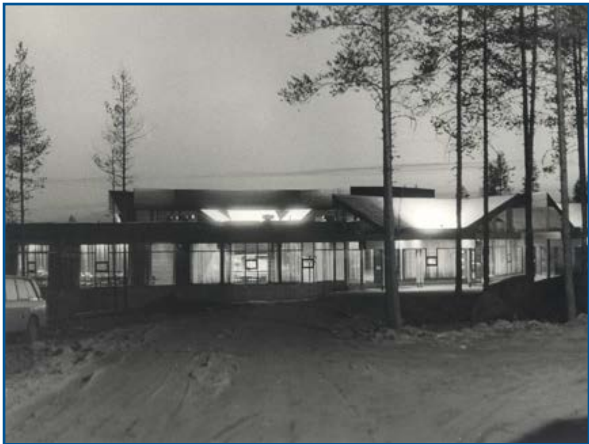
KUVA 82: Vanha arkistokuva kohdasta, jonka edustalle kokoussiipi rakennettiin vuonna 1989.
