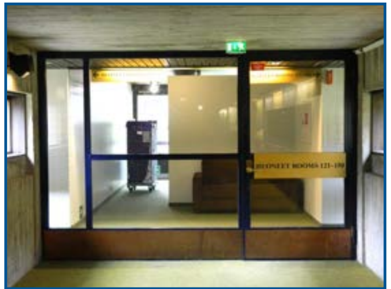
KUVA 52 (yllä): Alkuperäinen lasiseinä ovineen kalliokäytävän ja huoneistosiiven välissä. Myös värit ovat alkuperäisiä.
