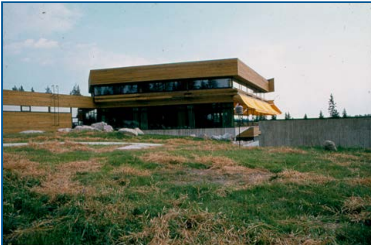
KUVA 84: Vanhassa arkistokuvassa näkyy hotellin ravintolaosaa sekä vasemmalla matala osa, jossa sijaitsi ennen hotellin WC-tiloja. Vanhat WC-tilat purettiin laajennuksen alta.
