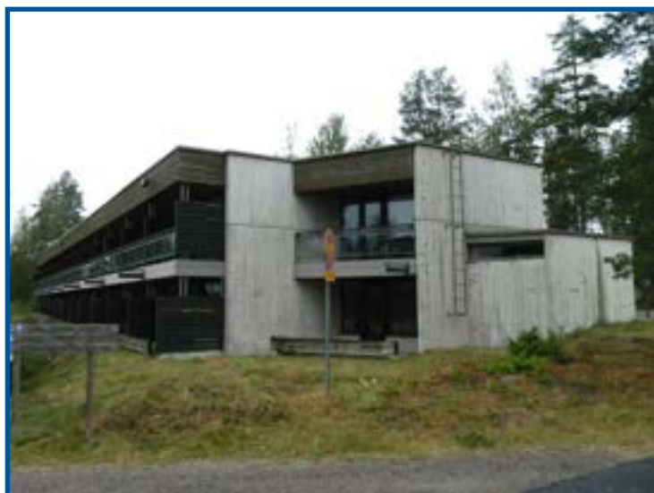
KUVA 60: Lisäsiipi kuvattuna vuonna 2019.
