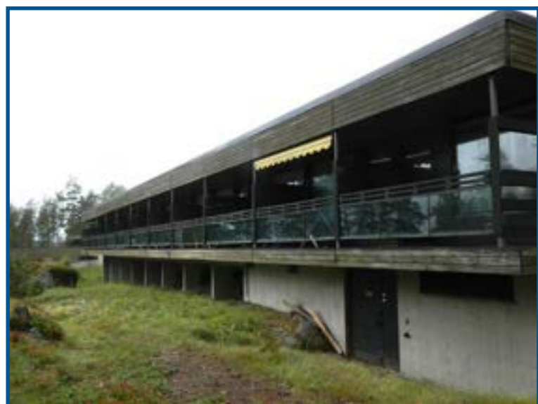
KUVA 54: Yksikerroksinen huoneistosiipi vuodelta 1976. Kuva otettu vuonna 2019.
