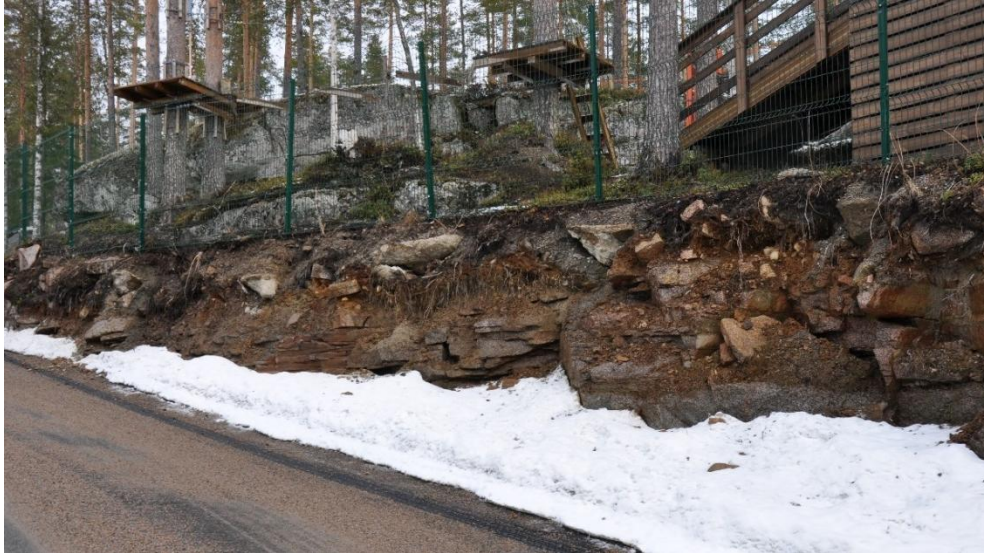
Kuva 4. Maaston leikkaaminen Ähtärihallin takana kulkevalla huoltotiellä vaatii tukimuurin rakentamisen.
