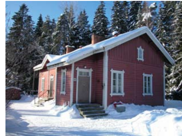
Inhan asemalla on kaksi erillistä asuinrakennusta, toinen niistä on ollut vahtitupa.
