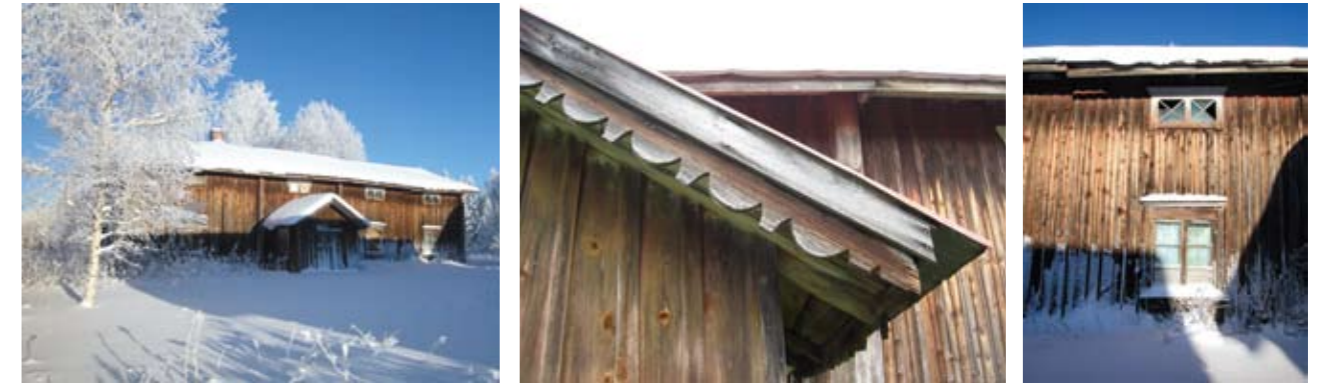
Vehmasmäen päärakennus talviasussa, keskellä yksityiskohta päärakennuksen kuistin koristelijoista, oikealla yksityiskohta päärakennuksen alkeperäisistä ikkunoista.
