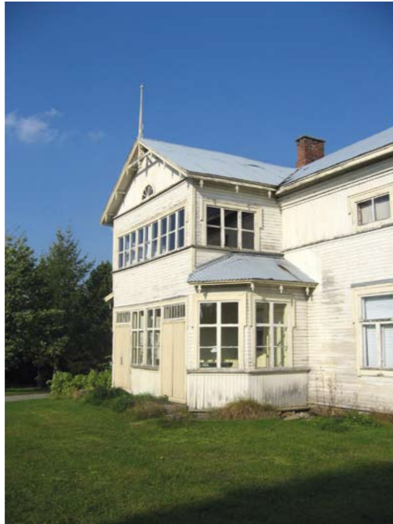
Kauppalan kaksikerroksinen kuisti
