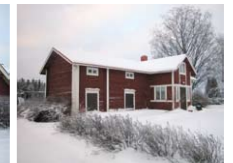
Sivurakennuksessa on asuin- ja aittatiloja
