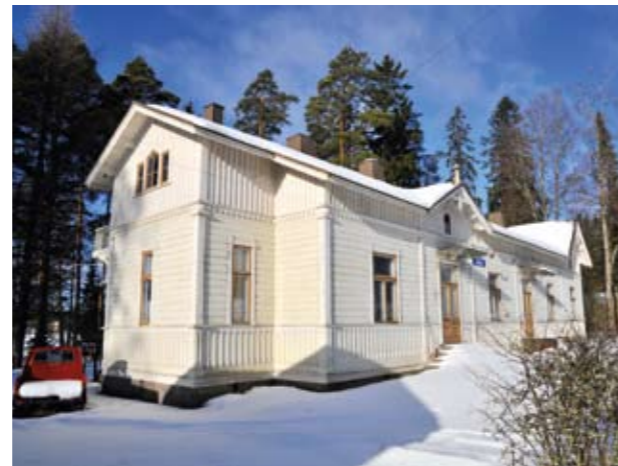
Inhan asemarakennus radan puolelta
