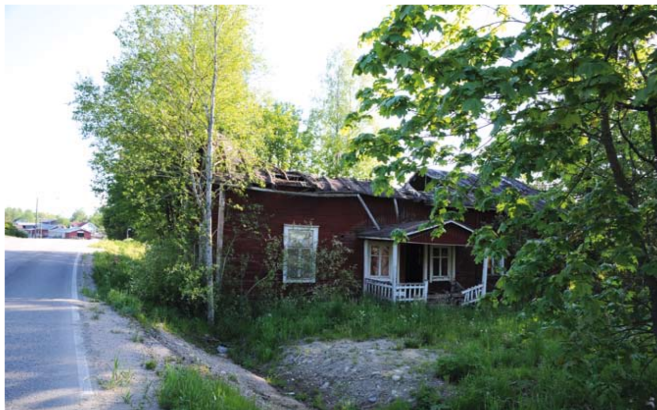
Erittäin heikkokuntoinen rakennus tienvarressa Ähtärinrannalla
