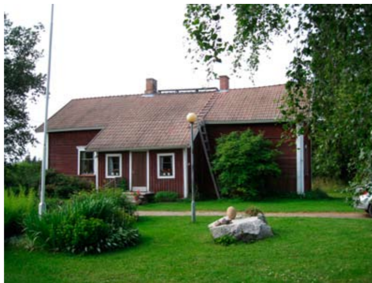
Mäkelän vanha päärakennus
