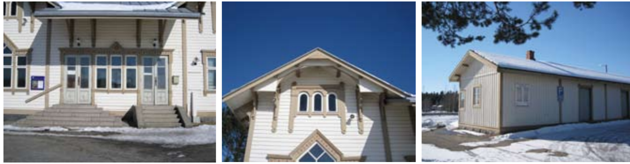
Ähtärin aseman pääsisäänkäynti vasemmassa, julkisivun yksityiskohta keskellä, oikealla ulkorakennuksen päätyä.
