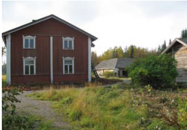
Kellomäen pihapiiri koostu useista rakennuksista.
